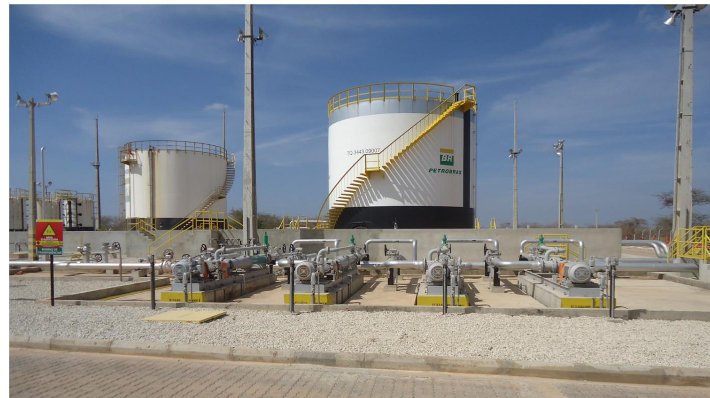
Fig. 2: Estação coletora (EC) - na foto é possível ver os tanques e as bombas de transferência para a estação central.
