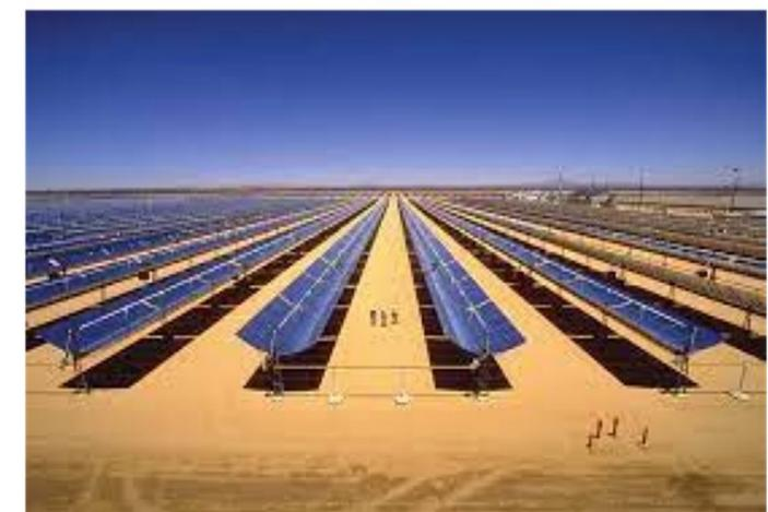
Coletores cilindro parabólicos
